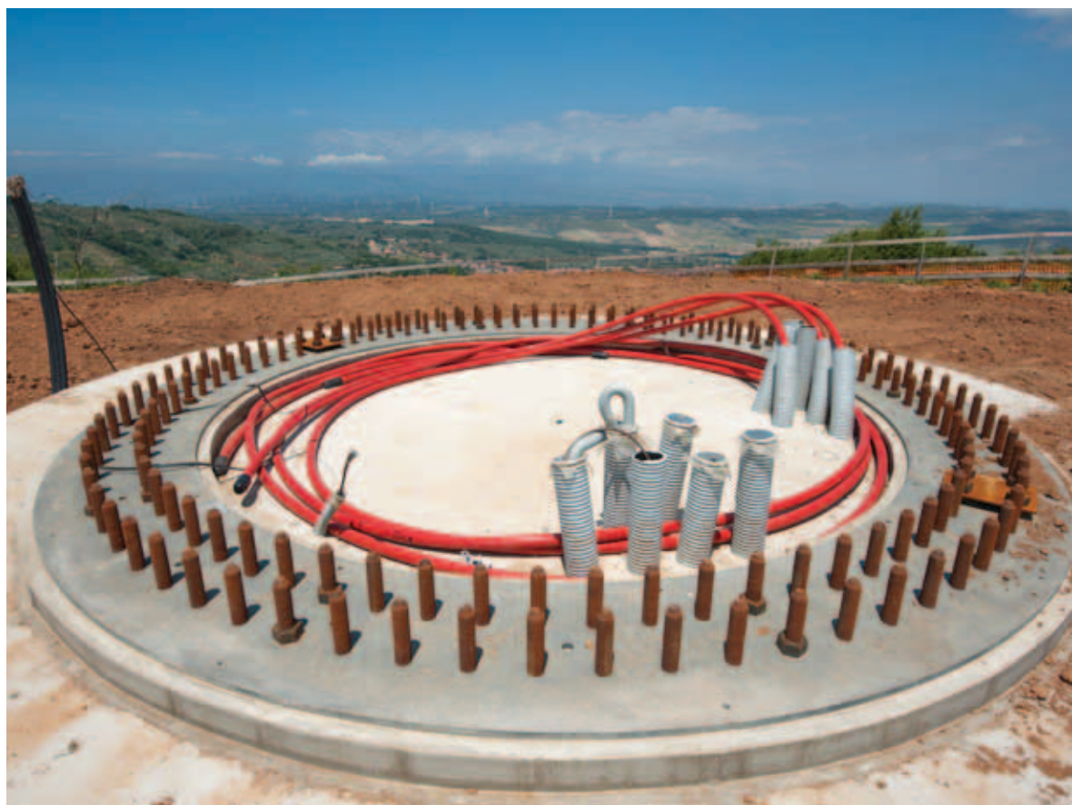
La fondazione di una turbina
