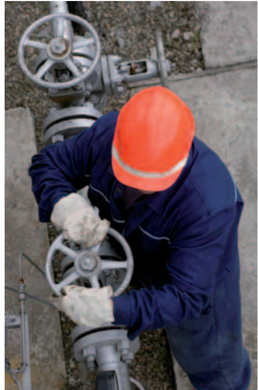
Manutenzione delle pipelines
