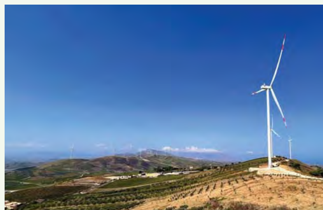
Il nuovo impianto installato a Partinico-Monreale
