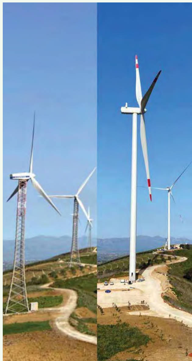
Repowering: prima e dopo
