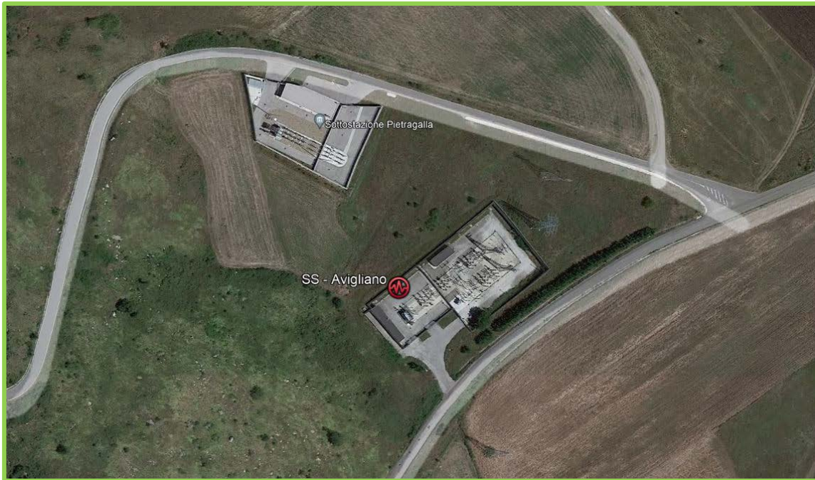
Figura 2 - Sottostazione elettrica "AVIGLIANO" afferente al Parco Eolico di AVIGLIANO (PZ).
