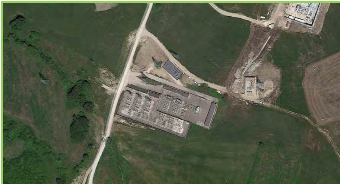
Figura 2 - Sottostazione elettrica "Foiano" afferente al Parco Eolico di Foiano-Molinara-Baselice (BN).
