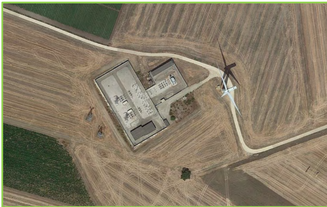
Figura 2 - Sottostazione elettrica "Poggio Imperiale" afferente al Parco Eolico di Poggio Imperiale (FG).
