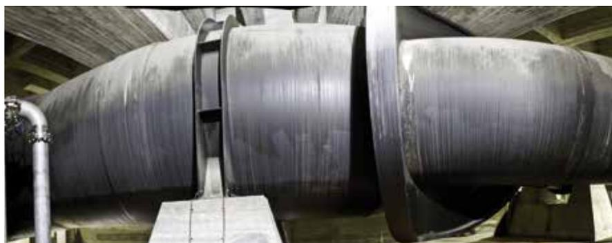
appoggiate sul versante, sia in caverna. Le manovre di regolazione dei deflussi vengono effettuate azionando appositi organi d'intercettazione (valvole rotative, a farfalla, paratoie) poste alle estremità delle condotte.
